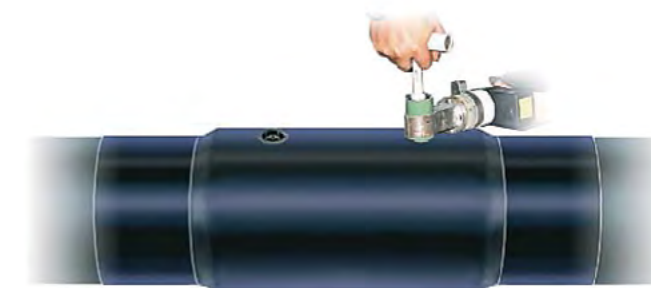
Рис. 16. Виконати гідроізоляцію заливних отворів за допомогою вварних конічних корків (або латок).
