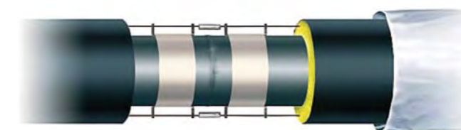
Рис. 7. Виконати монтаж дротів системи оперативного дистанційного контролю (СОДК).
