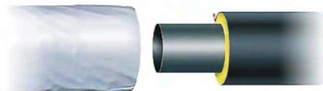
Рис. 2. Термоусадкову муфту розмістити на прилеглому краї попередньо ізолюваної труби перед зварюванням трубопроводу.
