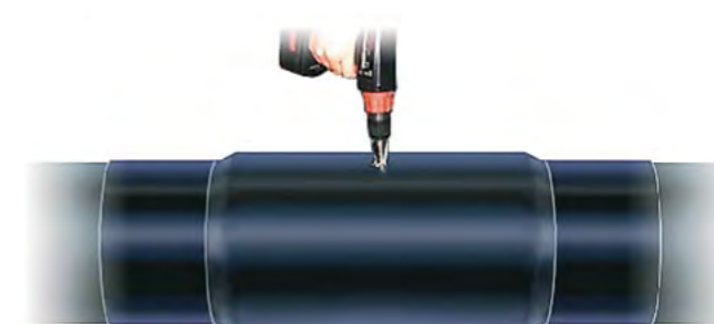
Рис. 13. Просвердлити конічним (перовим) свердлом отвори для перевірки герметичності зварного з'єднання.
